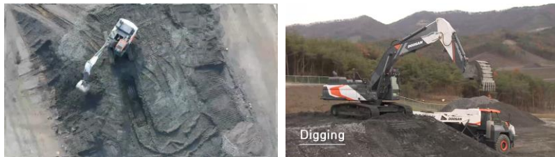
자동화굴삭기 전문가모사 굴삭작업 자율제어
